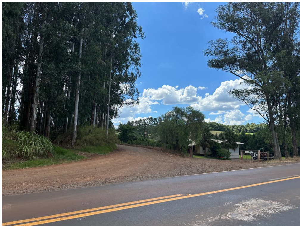
Foto 01 - Ponto Inicial da Obra de Pavimentação
