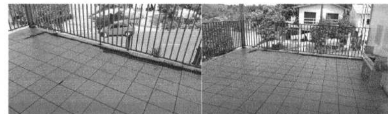
LOCAL PARA SUBSTITUIÇÃO DO PISO
