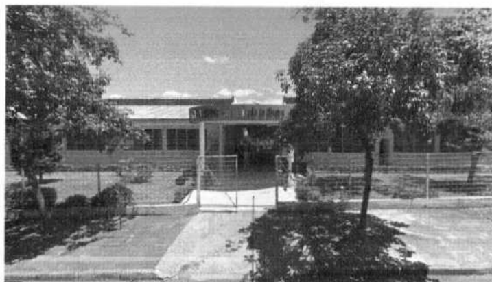
SUBSTITUIÇÃO DE PISO
