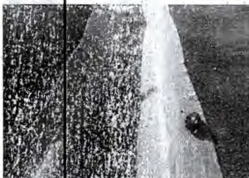
Figura 7 Colocação da manta geotêxtil no fundo da vala
