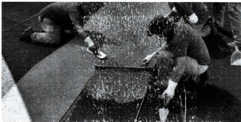
Figura 35 Assentamento da camada de superfície - 2ª camada
