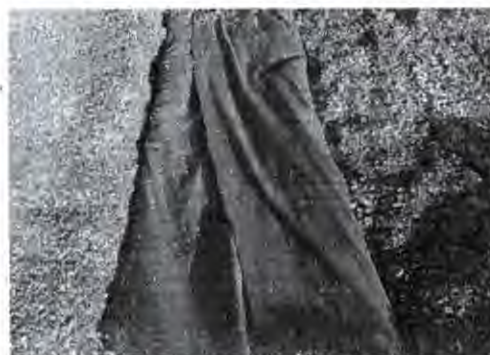
Figura 9 Fechamento da vala com manta geotêxtil
