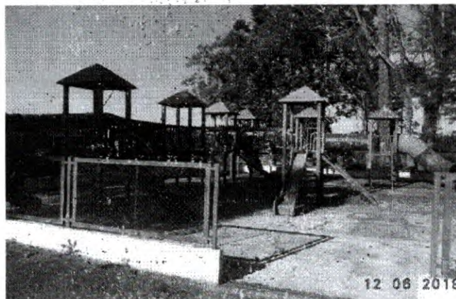
Figura 38 Playground antes da reforma
