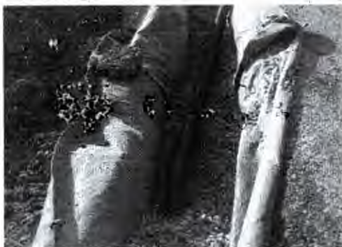
Figura 8 Colocação de brita e tubo sobre a manta geotêxtil
