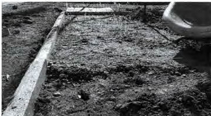
Figura 31 Execução de base em pó de pedra
