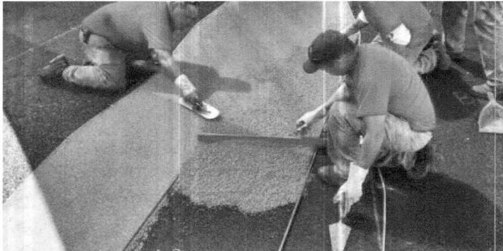
*Figura 6 Assentamento da camada de superfície - 2ª camada*
