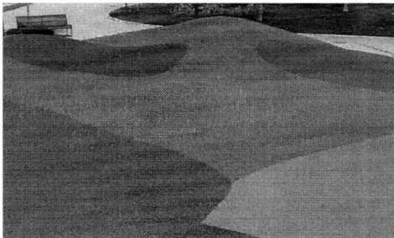
Figura 8 Piso acabado, com esperas para instalação de playground
