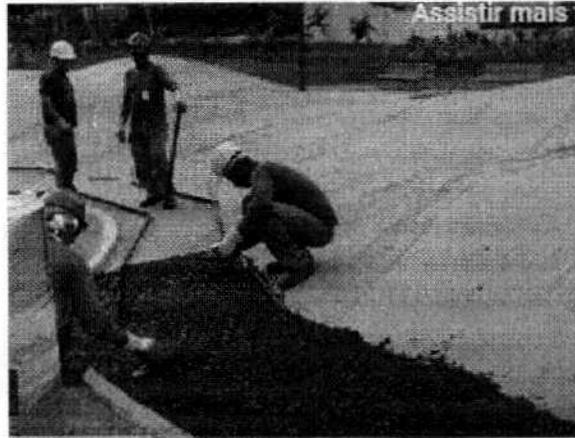
Figura 5 Instalação da primeira camada de piso emborrachado
