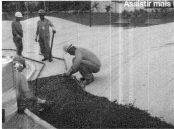
Figura 5 Instalação da primeira camada de piso emborrachado
