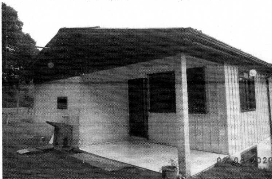
Foto 02 – Fachada Casa Rua João Scapinello (Nelci)
