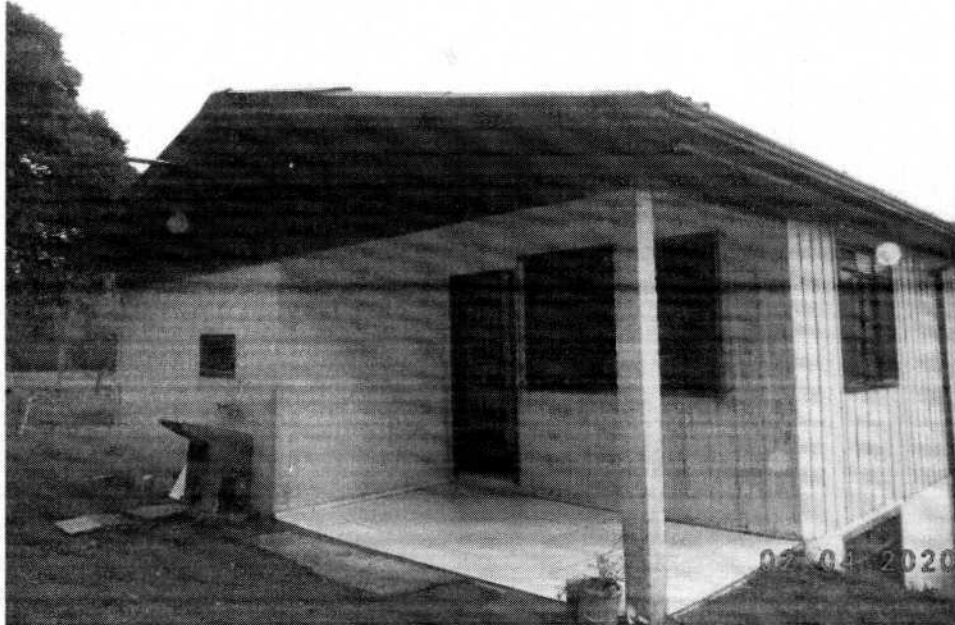
Foto 02 – Fachada Casa Rua João Scapinello (Nelci)
