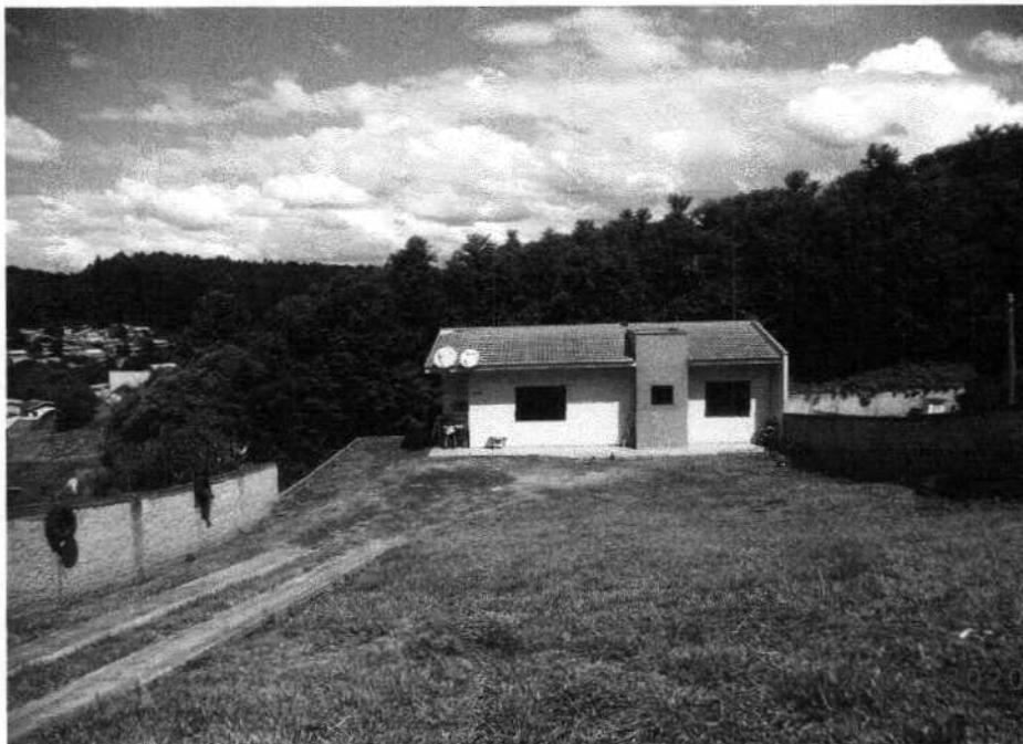
Foto 02 - Casa em alvenaria no Lot. Pedro Szura
