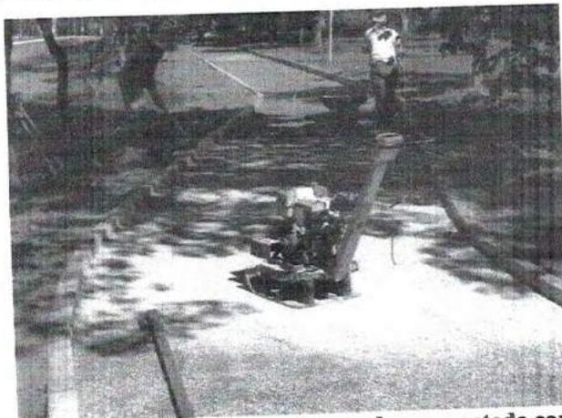
Figura 4 - Foto ilustrativa de sub-base granular sendo compactada com placa vibratória.
