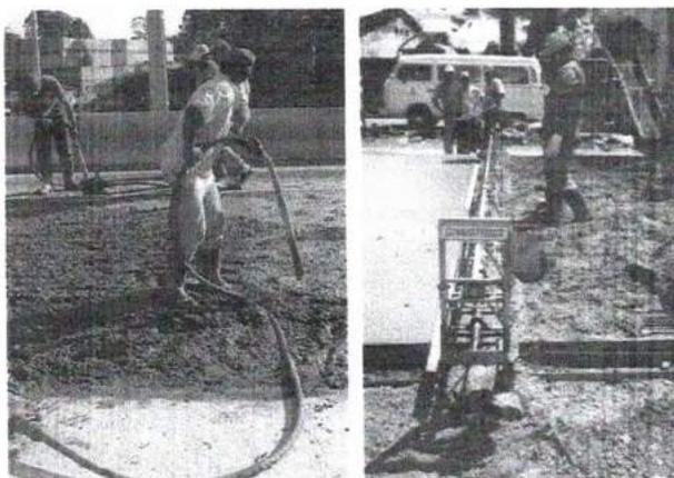
Figura 6 - Ilustração da execução de adensamento do concreto com uso de vibradores e régua vibratória.
