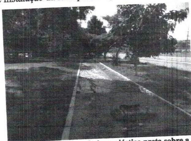
Figura 5 - Foto ilustrativa da instalação da lona plástica preta sobre a sub-base granular.
